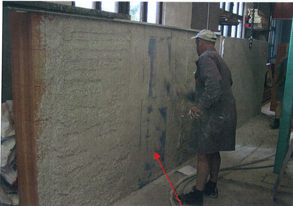
BAUMIT TextilglasGitter im Putz im Stoßfugenbereich eingearbeitet
